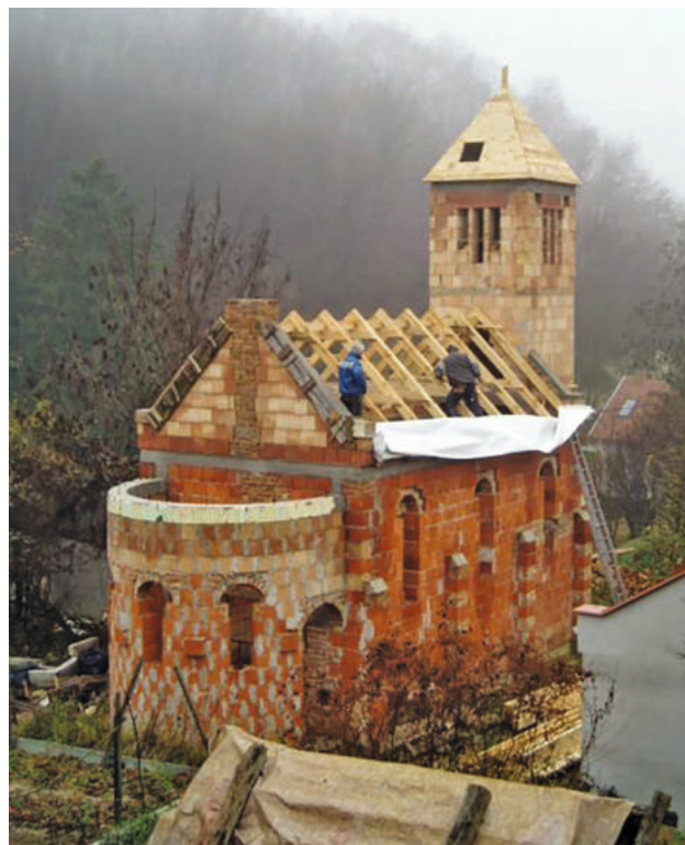
Az épülő kápolna 2009 decemberében
